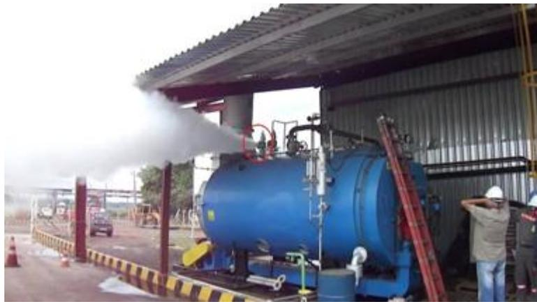
**Figura 2.5:** Exemplo de válvula de segurança instalada em uma caldeira (CALTEC CALDEIRAS).
