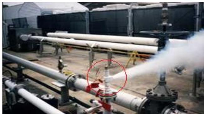
**Figura 2.6:** Exemplo de válvula de segurança instalada em uma tubulação (FLOWSAFE).
