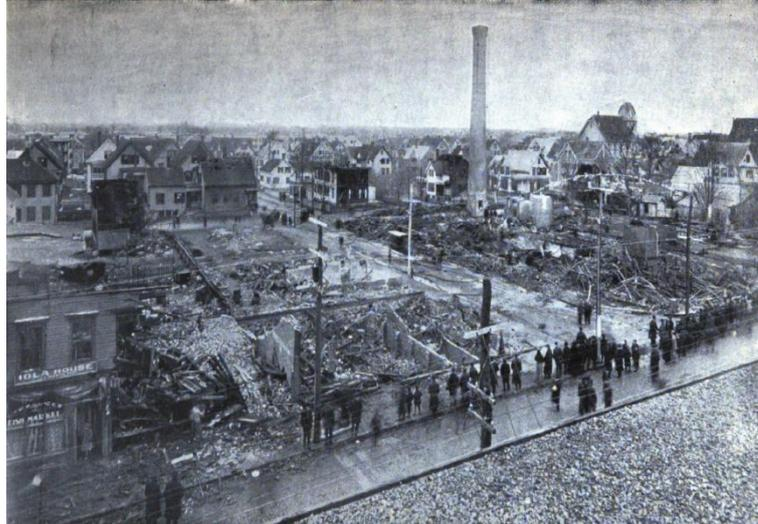
**Figura 2.11:** Fábrica *Shoe Grover* depois da explosão da caldeira (FERREIRA, 2013).
